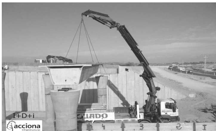
Rys. 4. Montaż belek kompozytowych (oprac. BSiR Mostostal SA)
