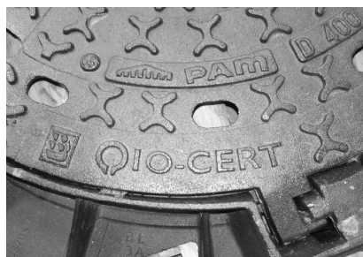
Rys. 6. Oznakowanie włazu przeznaczonego na rynek polski: obowiązkowy znak budowlany „B” oraz znak jednostki certyfikacyjnej IO-CERT.
