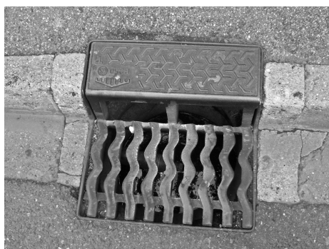
Rys. 3. Umiejscowienie wpustu krawężnikowego
