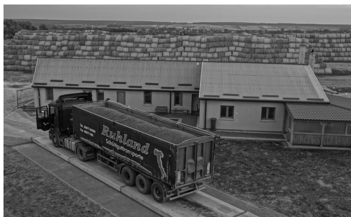
Rys. 1. Zakład produkcyjny - widok na wagę najazdową, budynek administracyjny i plac składowy Źródło: materiały promocyjne firmy
