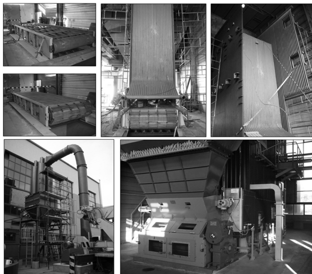
Rys. 1. Postęp prac przy modernizacji kotła K4-WR-10-012 [14]
