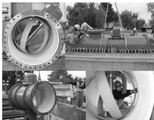
Rys. 1. Turbina wewnątrz wodociągu
