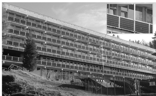
Rys. 2. Instalacje fotowoltaiczne w szpitalu zdrojowym z Łądku-Zdroju
