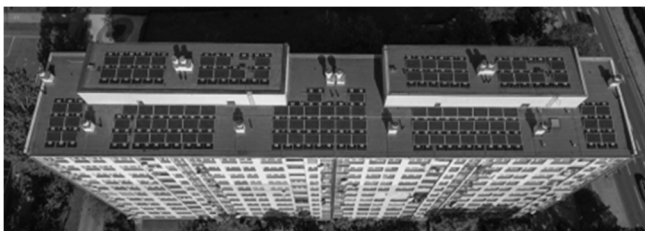
Rys. 3. Instalacja PV na jednym z dachów Spółdzielni Mieszkaniowej Wrocław-Południe [11]
