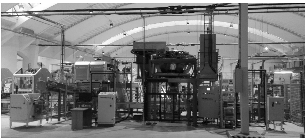
Rys. 2. Widok na stanowisko do konfekcjonowania
